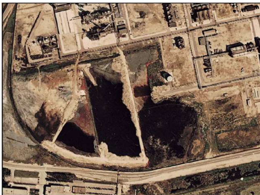
Figura 59. Fase di realizzazione di una discarica all'interno dell'area del Petrolchimico di Porto Marghera, 2003. (22)
