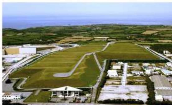
*Deposito di superficie per circa 500'000 m<sup>3</sup> di rifiuti radioattivi a bassa e media attività, provenienti da attività nucleari, di ricerca, medicina ed industria. Entrato in esercizio nel 1969, completato nel 2004, il deposito è sotto controllo istituzionale dal 2003. (31)*
