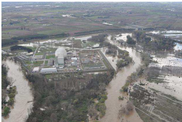
Figura 18. Allagamento della ex centrale nucleare Garigliano (2009) (72)
