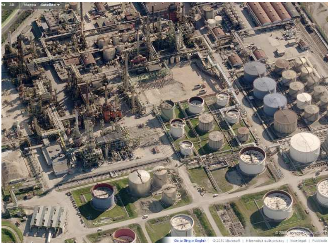
Figura 6. L'impianto della Raffineria
