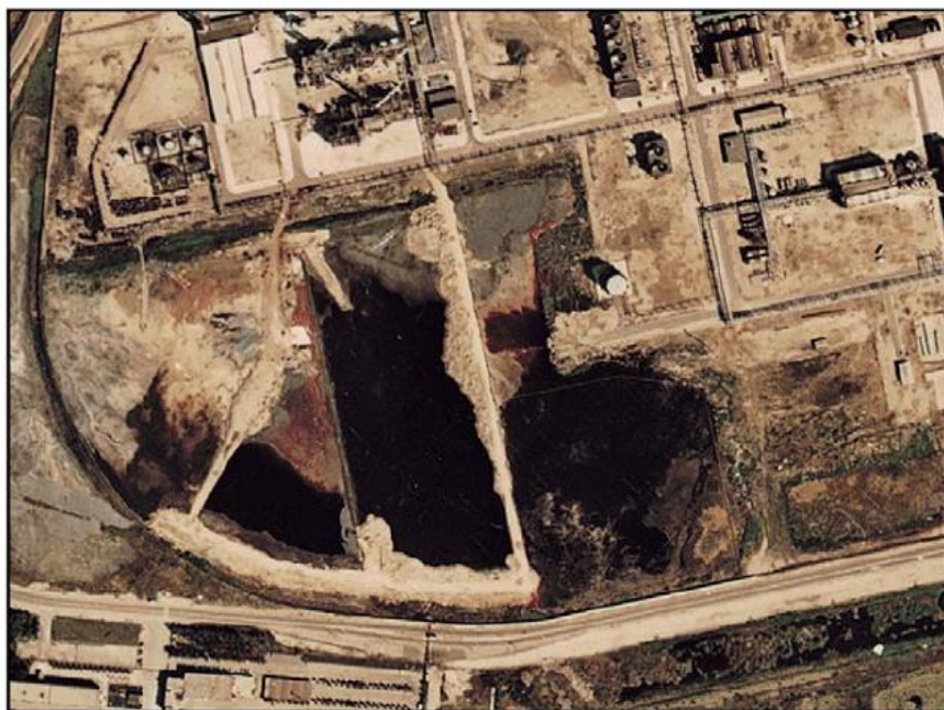
Рисунок 59. Этап строительства свалки на территории Нефтехимического Центра Порты Маргера, 2003 г. (22)
